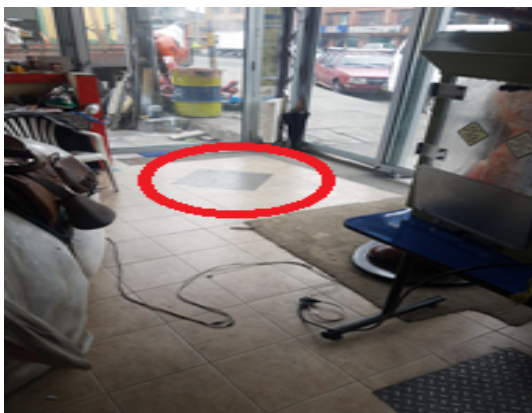
Fotografía 1. Localización aparente del pozo pz-12-0026
