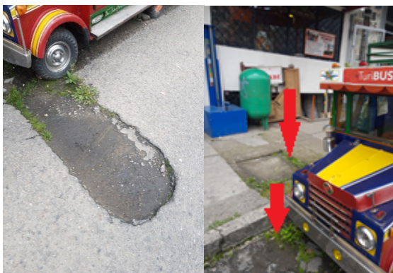
Fotografía 10. Instalación de la tubería de desagüe hacia la red de la principal de la EAB.
